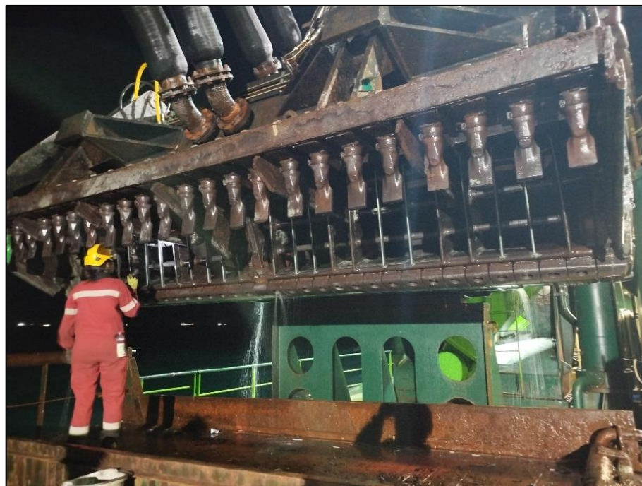
Figura 10. Particolare della testa durante le fasi di ispezione sulla Lange Wapper
